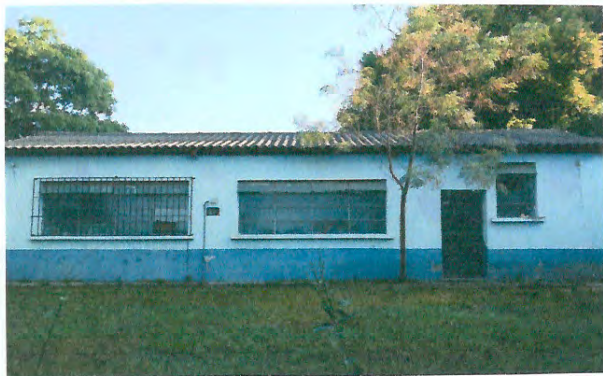
Foto 1: Sustitución de Techo Del Modulo 3 a laminado Trequelada calibre 26 y mejoramiento de estructura portante
